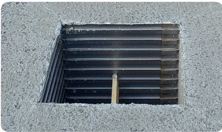
Mise en béton.
