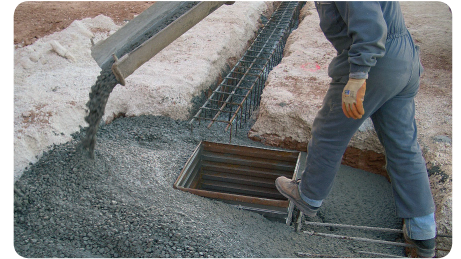
Remplissage de l'espace extérieur du CUBIX.
