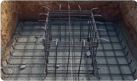
Préparation du fosse.
