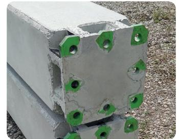
Le pied de pilier est inséré dans la phase de construction du armure de pilier. Il est recommandé d'utiliser des moules récupérés câbles et vis d'entraînement pour la base du pilier.
